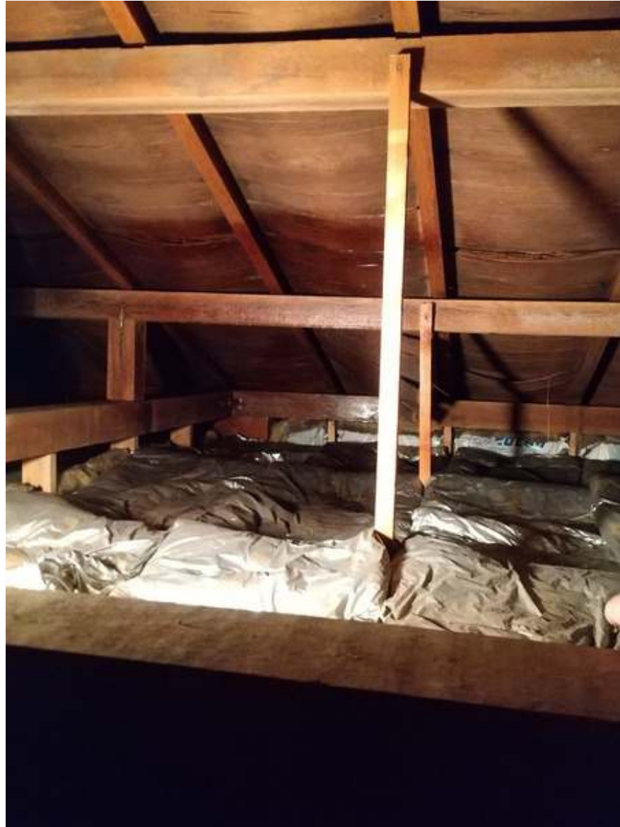
屋根裏の雨漏り箇所点検
